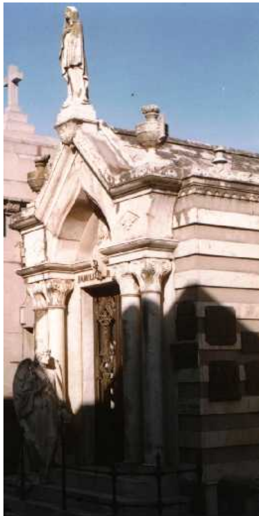
(fig. 13, capilla Rouillon, pórtico, fotografía V.N.)
