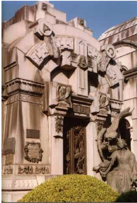
(fig. 45, capilla Carreras, fotografía V.N.)
